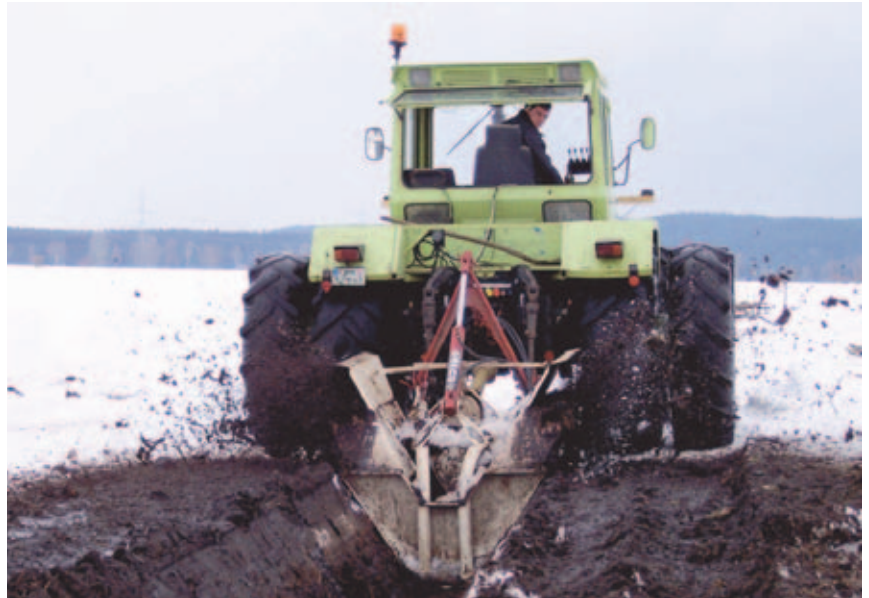
Abb. 14 Die Grabenfräse im Einsatz
